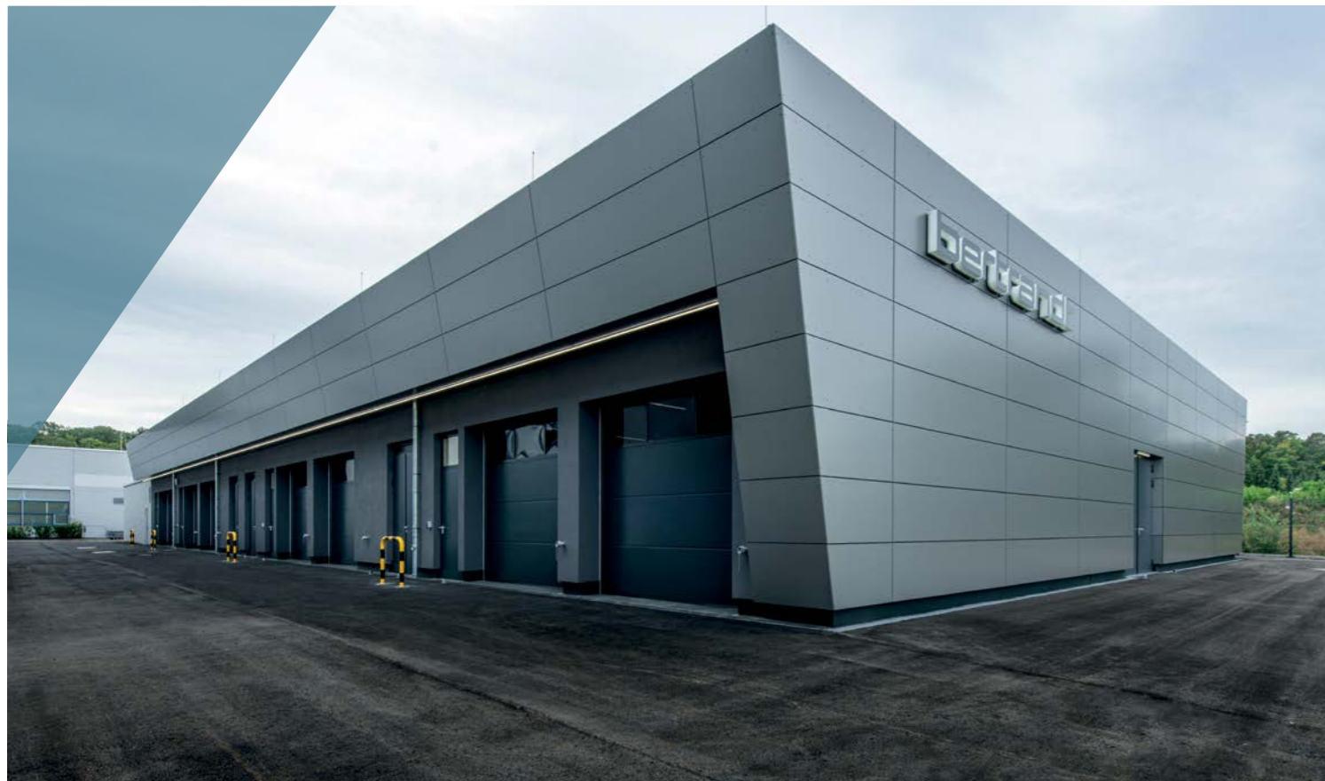
Das Bertrandt Hochvolt-Prüfzentrum steht allen Kunden zur Verfügung.
